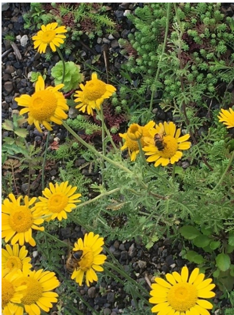
Begrünung der Dachfläche
