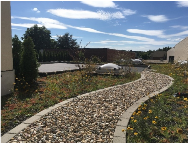
Begrünung der Dachfläche
